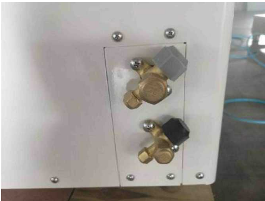
Złącze gazowe jednostki zewnętrznej
